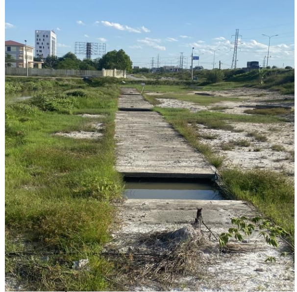
Tuyến mương hiện trạng tại dự án
